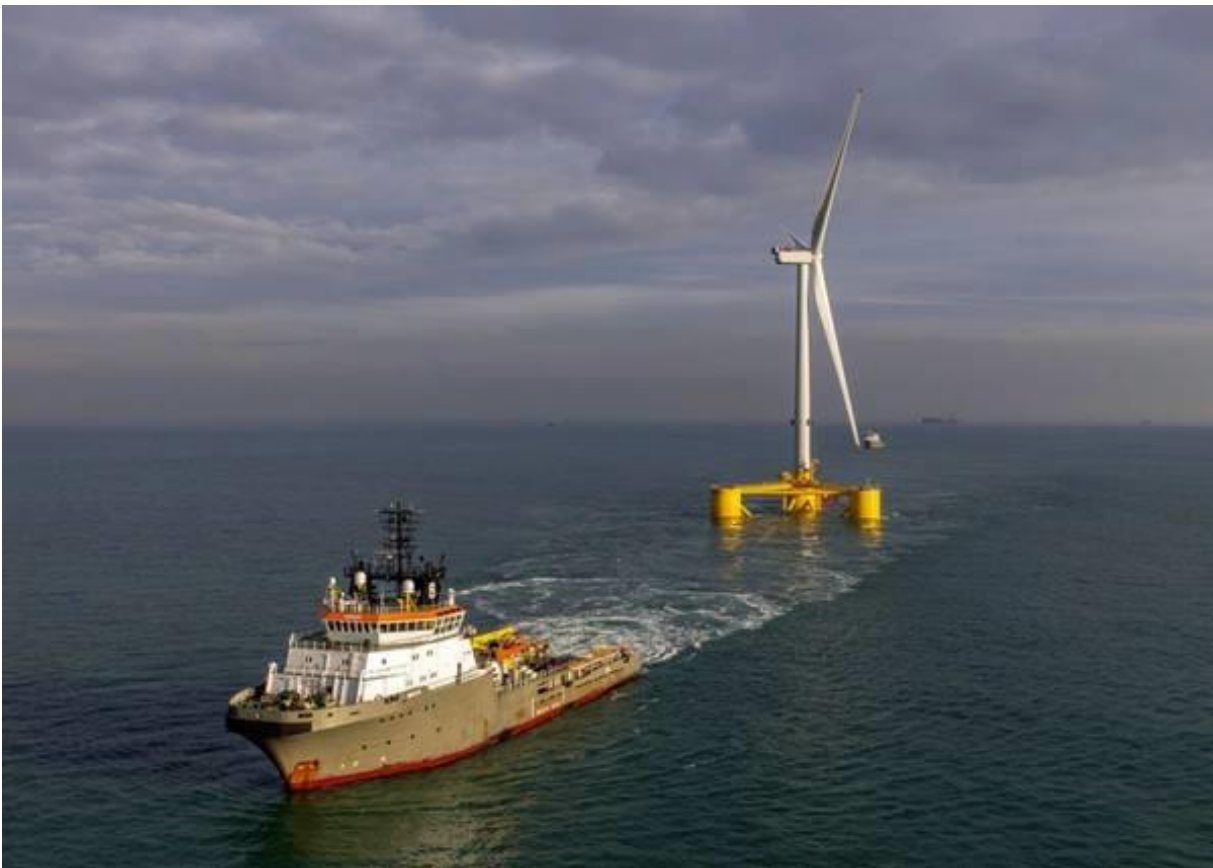
Figur 8. Bogsering av ett 9,5 MW vindkraftverk på semisubmersible fundament (Tomic 2020). (Foto Boskalis.)
